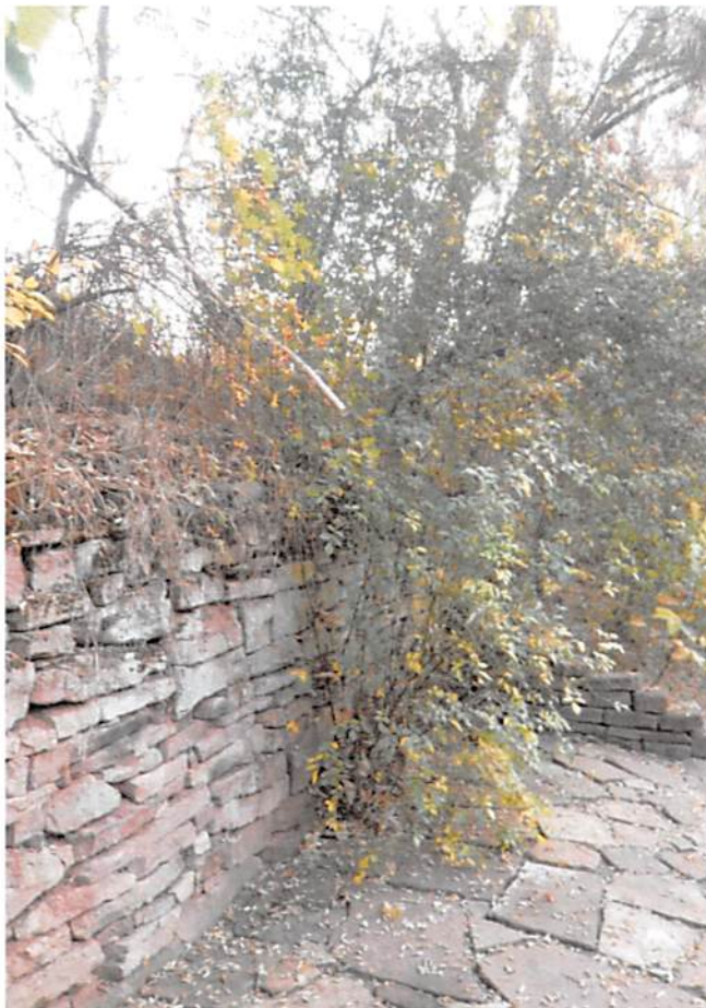
Natursteinmauer (Aufnahme Büro LP)
